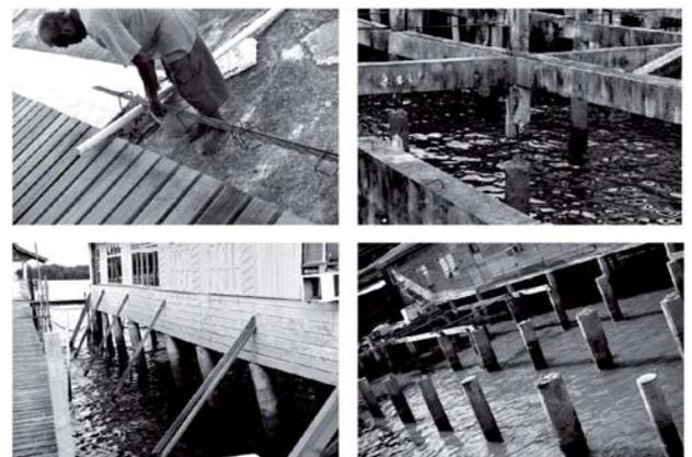
図 4 水上集落における構造的欠陥
