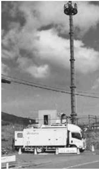
図 5: NTT ドコモの災害用基地局([7]より転載)
