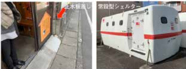
図 37 : 家屋玄関の止水版, 避難シェルターの様子
